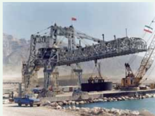
طراحی و ساخت جرثقیل نصب قطعات کیسون ۱۲۵۰ تن متر
