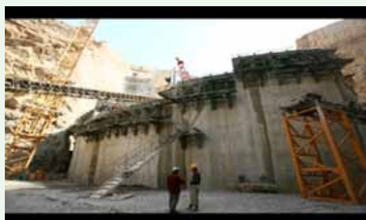
طراحی و ساخت قالب بدنه سد
