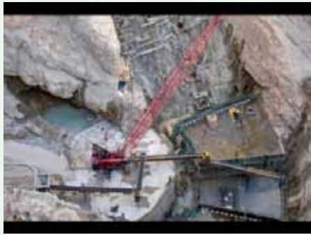
بعد از طراحی و بازسازی جرثقیل ۲۲۵ تنی مانیتواکو طراحی و ساخت تاپ‌بلت
