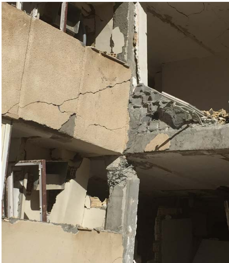
تصویر-۱۰: تعدادی از ساختمان‌های مسکن مهر اسلام آباد غرب
