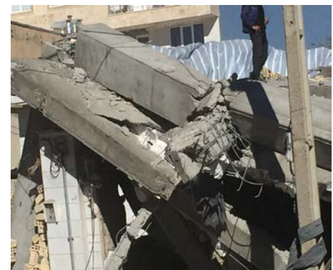
تصویر-۹: اسکلت بتنی شخص ساز اسلام آباد غرب
