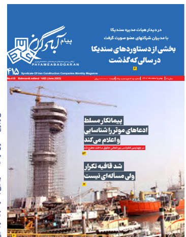
ساختمان و برج کنترل ترافیک دریایی شهید رجایی
