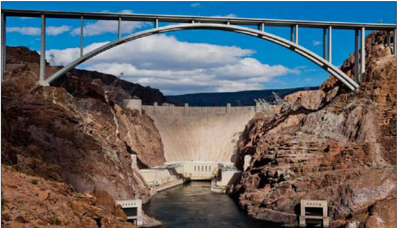
سد هوور؛ یکی از شناخته شده‌ترین سازه‌های آبی جهان / نمونه‌ای کلاسیک از مدیریت زیرساخت‌های آبی و نگهداری پیشگیرانه در مقیاس ملی
