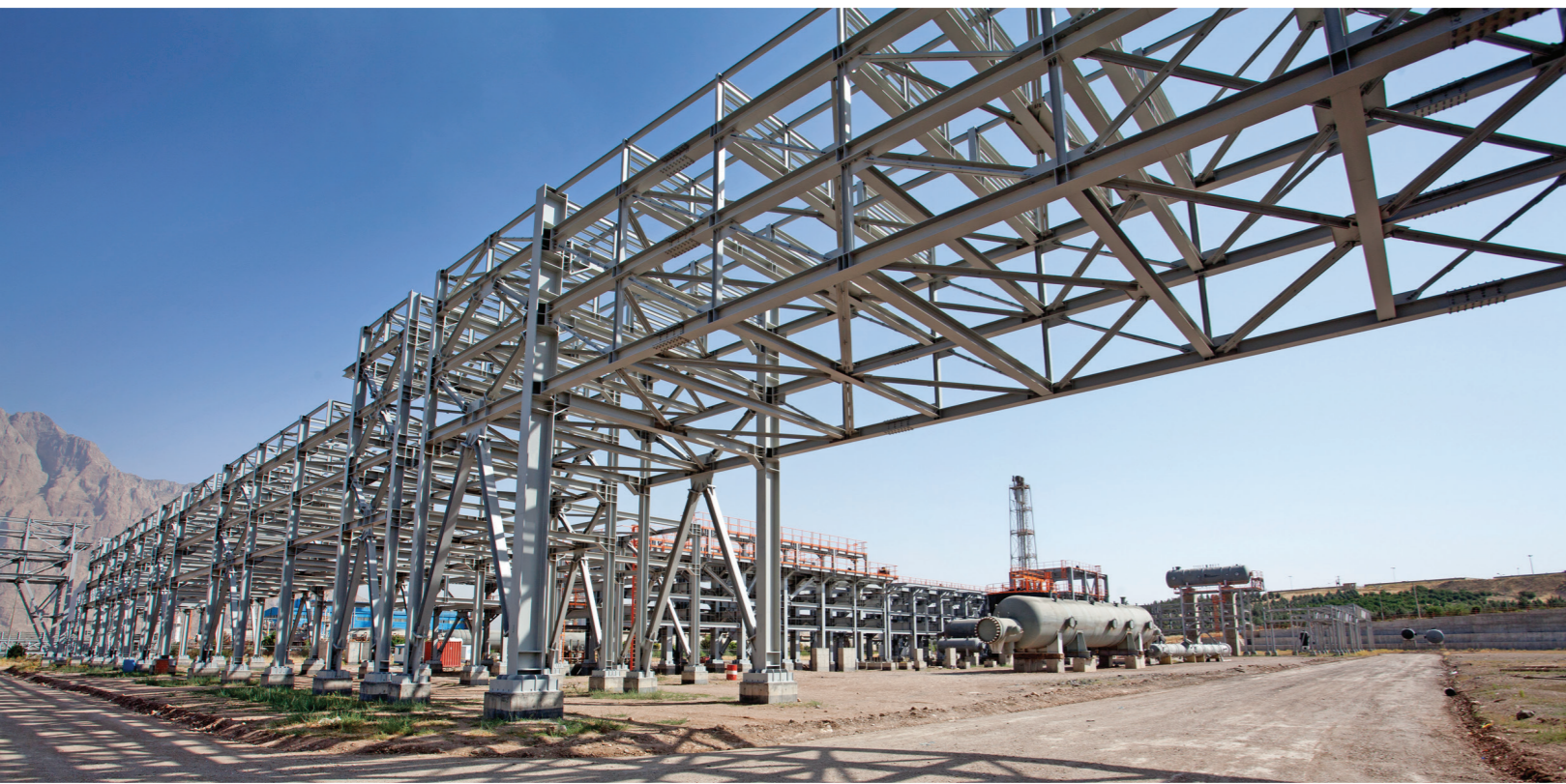
سازه های فلزی واحد آمونیاک صنایع پتروشیمی کرمانشاه | ۶۰۰۰ تن
