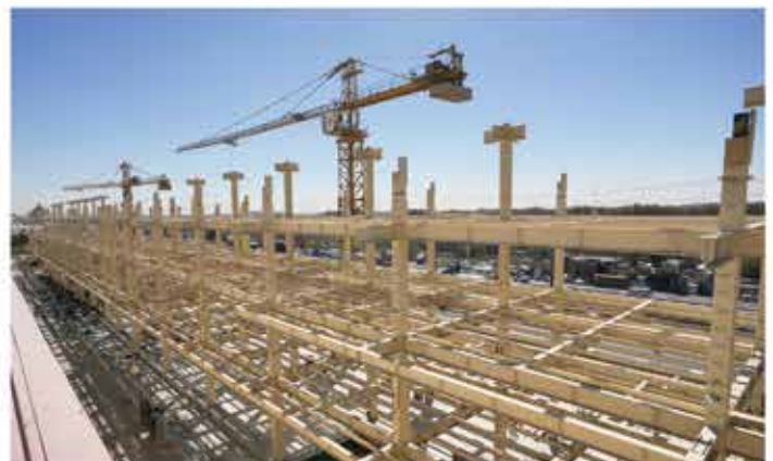
سازه های فلزی ساختمان اداری کارخانه شماره ۳ شرکت کروژ | ۳۵۰۰ تن
