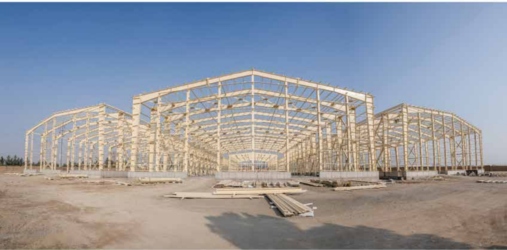
سازه های فلزی چهارپایه سوله کارخانه شماره ۴ شرکت کروژ | ۳۰۰۰ تن
