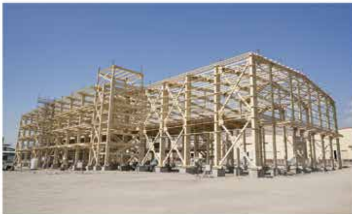
سازه های فلزی اکسترودر کارخانه شماره ۴ شرکت کروژ | ۱۲۰۰ تن
