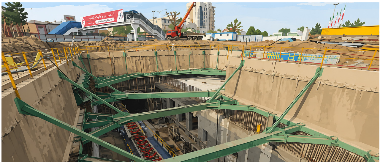
کارگاه احدث متروی مشهد؛ نمونه‌ای از توسعه زیرساخت‌های حمل‌ونقل شهری در خراسان رضوی
