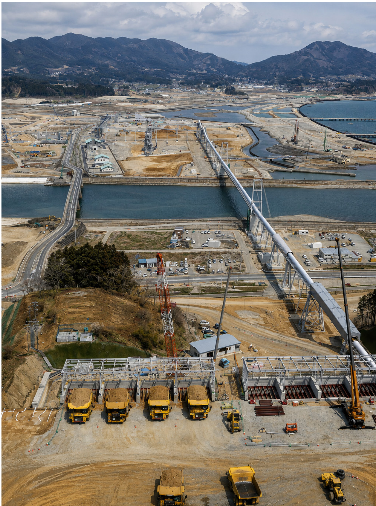
عملیات بازسازی و انتقال خاک در ریکوزنتاکاتا، استان ایواته ژاپن، پس از زلزله و سونامی ۲۰۱۱؛ سامانه نوار نقاله عظیمی برای جابه جایی سریع خاک و آماده سازی زمین در مقیاس وسیع احداث شد.
