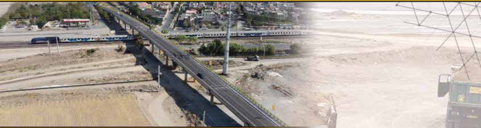
پروژه EPC پل بزرگ راه و راه آهن ورامین
