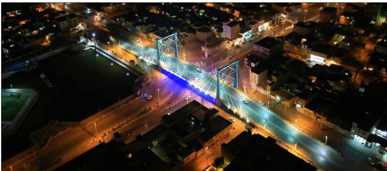
پل کابلی آبادان
